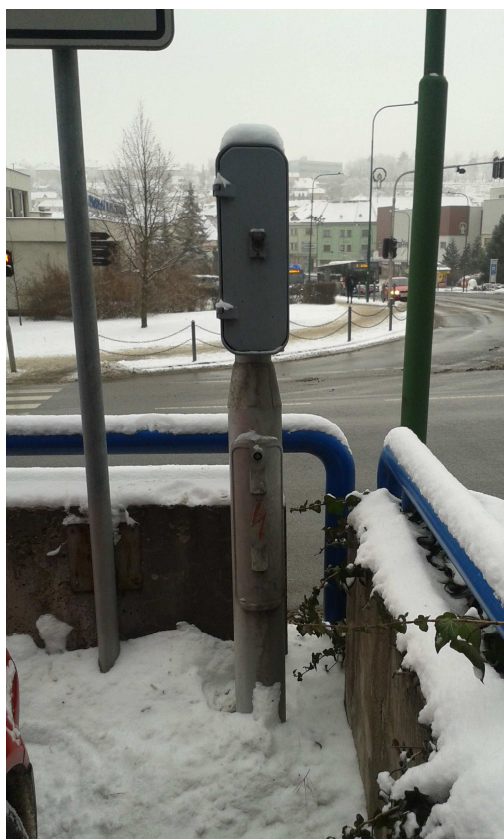
Obr. 3 Pohled na sloupek ručního řízení Rř
