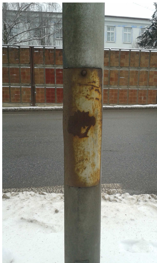
Obr. 7 Pohled na degradaci sloupu SSZ 11
