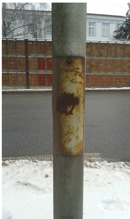
Obr. 7 Pohled na degradaci sloupu SSZ 11
