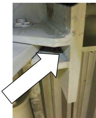
OBR: 17 – Tupý svar bez provařeného kořene
