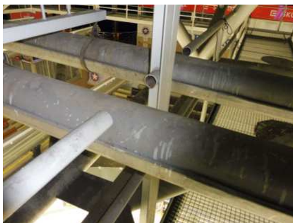
OBR: 32 – Přerušené zábradlí v místech křížení se svody
