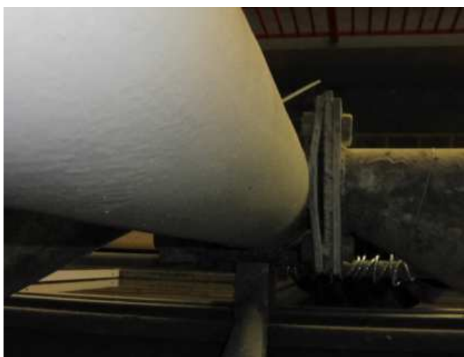
OBR: 18 – 20 - Rozevřené příruby v přípojích bočních vykonzolovaných konstrukcí
