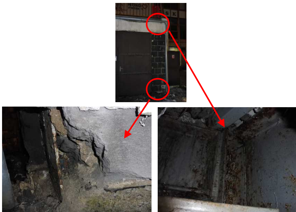
OBR: 25 – 27 – Zdegradovaná zděná konstrukce přístřešku pro rolbu
