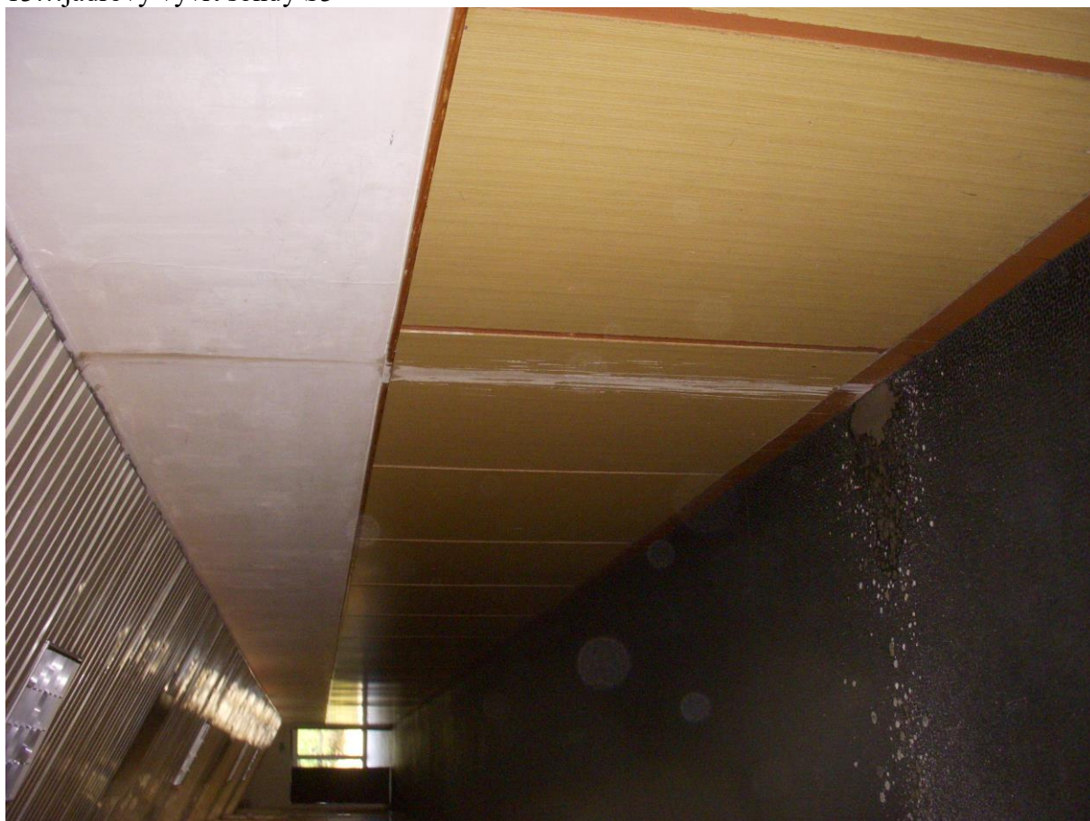
14... zatečení podhledu v místě sondy S3
