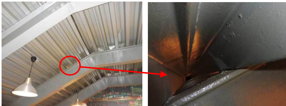
OBR: 23, 24 – Neidentifikovatelný přípoj TRplechu k nosníku tribuny
