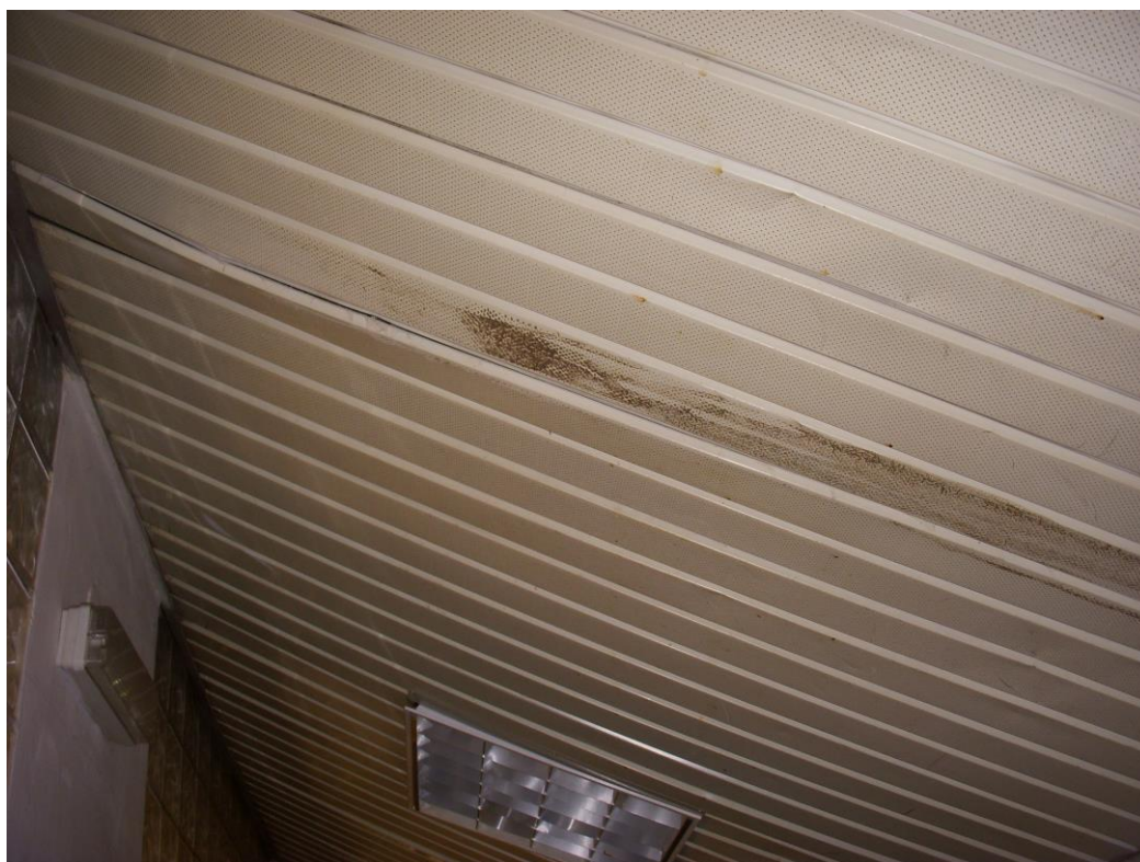
15...detail zatečení podhledu v místě sondy S3
