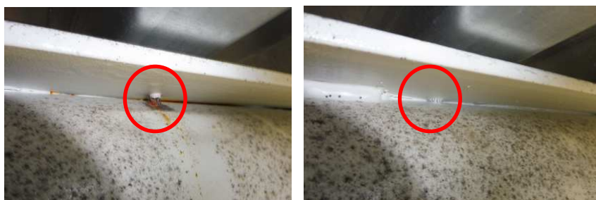
OBR: 08, 09 – Provrtané horní pasy příhradových vazníků
