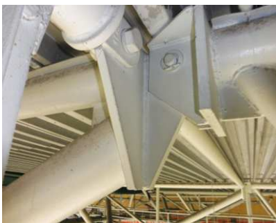
OBR: 15, 16 – Neobvykle malý průměr čepu / šroubu
