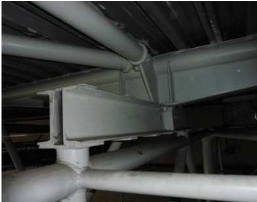
OBR: 21 – Uložení příčného nosníku bez výztuhy
