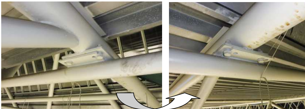
OBR: 10, 11 – Nepřesně spasovaná konstrukce
