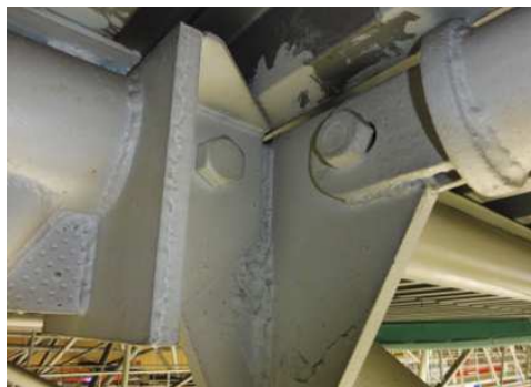
OBR: 05 – Propálený otvor pro šroub – doplněn montážní svar
