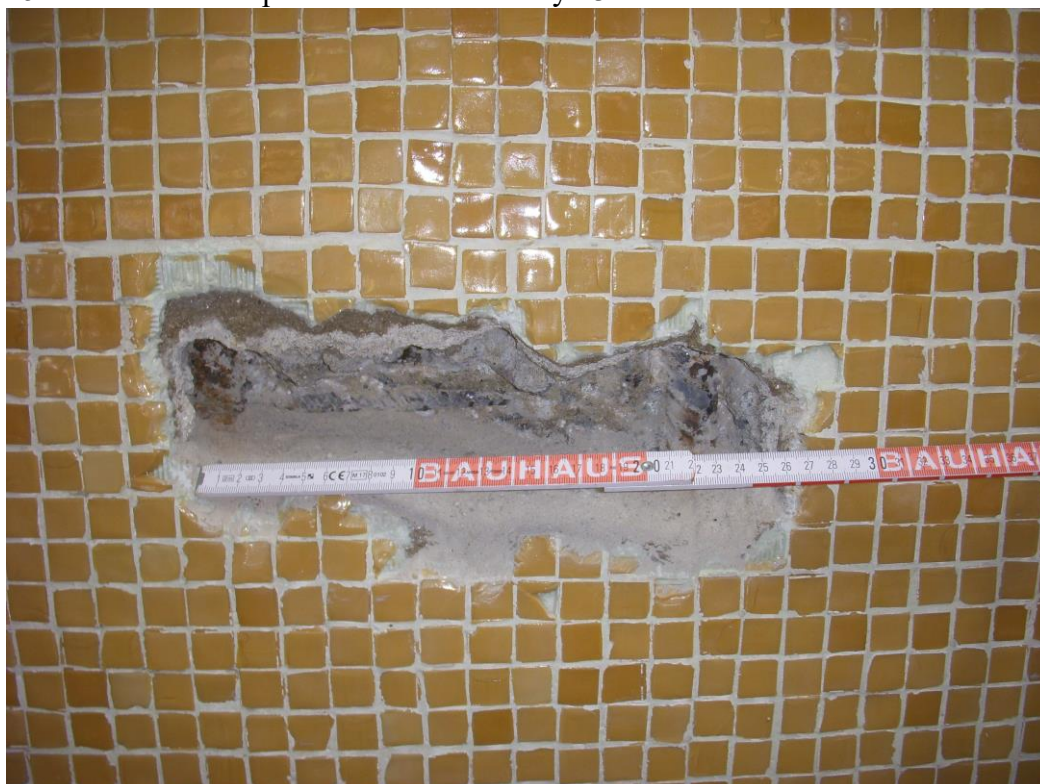
16... odkrytá hlavní výztuž stěny pod vazníkem v místě S4
