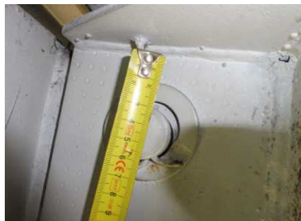
OBR: 15, 16 – Neobvykle malý průměr čepu / šroubu
