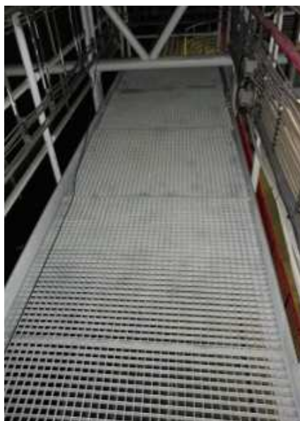
OBR: 31 – Chybějící spojky pororoštů
