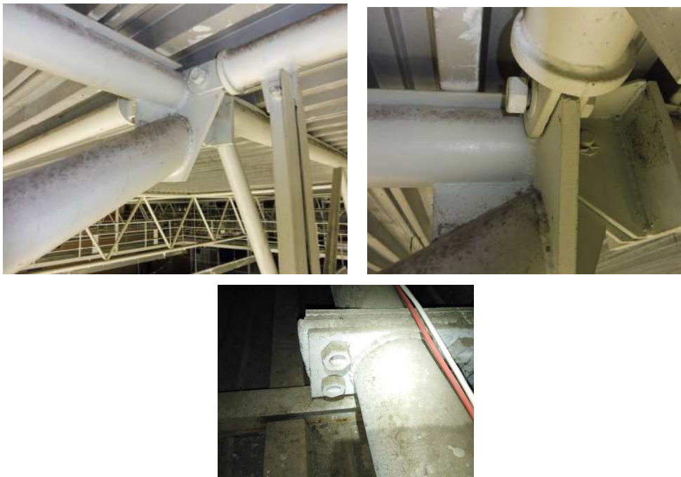
OBR: 28A, 28B, 29 – Volné, nebo krátké spojovací prostředky
