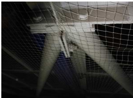
OBR: 14 – Rozevření příruby v podpoře hlavního trojbokého průvlaku
