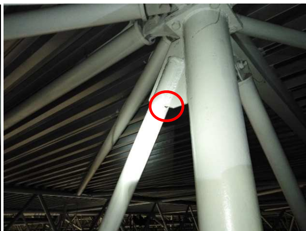
OBR: 22A – Vylomená část stěny trubky ztužení / 22B – Neuzavřený svar
