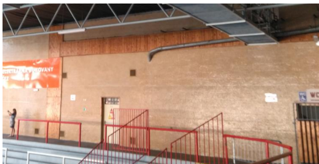
Obr. 7: Vedení potrubí v podstřeší
