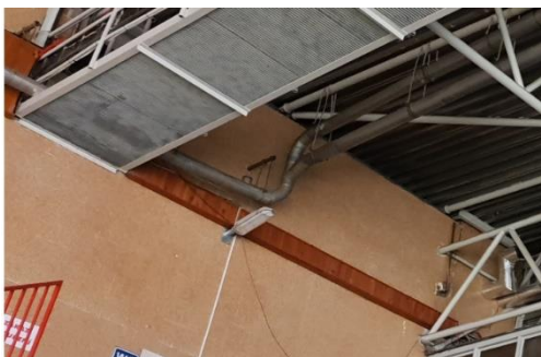
Obr. 6: Vedení potrubí v podstřeší
