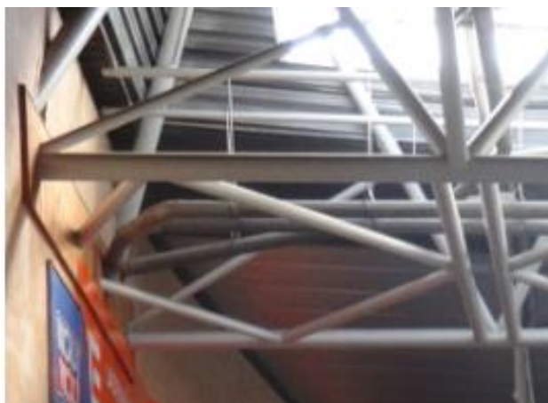
Obr. 5: Ocelové příhradové vazníky
