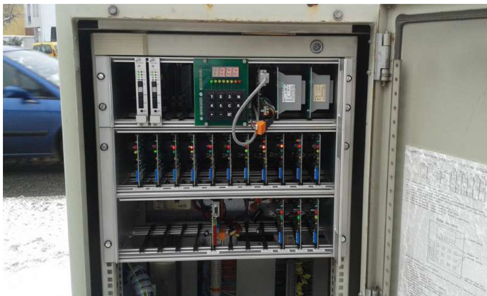
Obr. 3 Pohled so stávajícího řadiče RS-2 – chybí signalizace žluté
