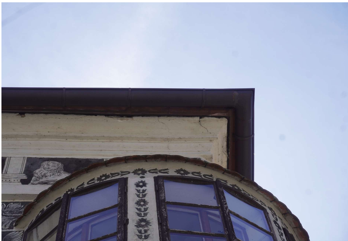
Obr. 03: Horní část Malovaného domu. Viditelné praskliny a chybějící místa na římse pod střechou.
