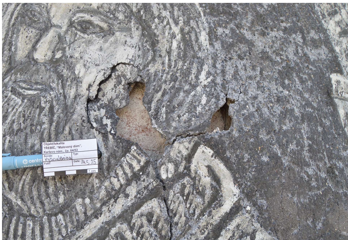
Obr. 05: Vybouleniny a chybějící omítky na portrétu muže na arkýři.
