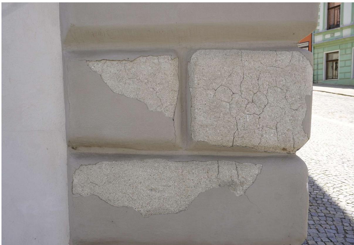
Obr. 17: Omítky na bosovaném nároží jsou popraskané, ale soudržné. Druhotná barevná vrstva z části chybí.
