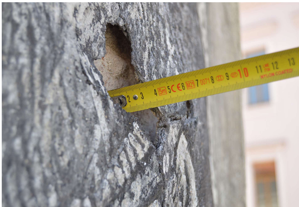
Obr. 05: Vybouleniny a chybějící omítky na portrétu muže na arkýři.
