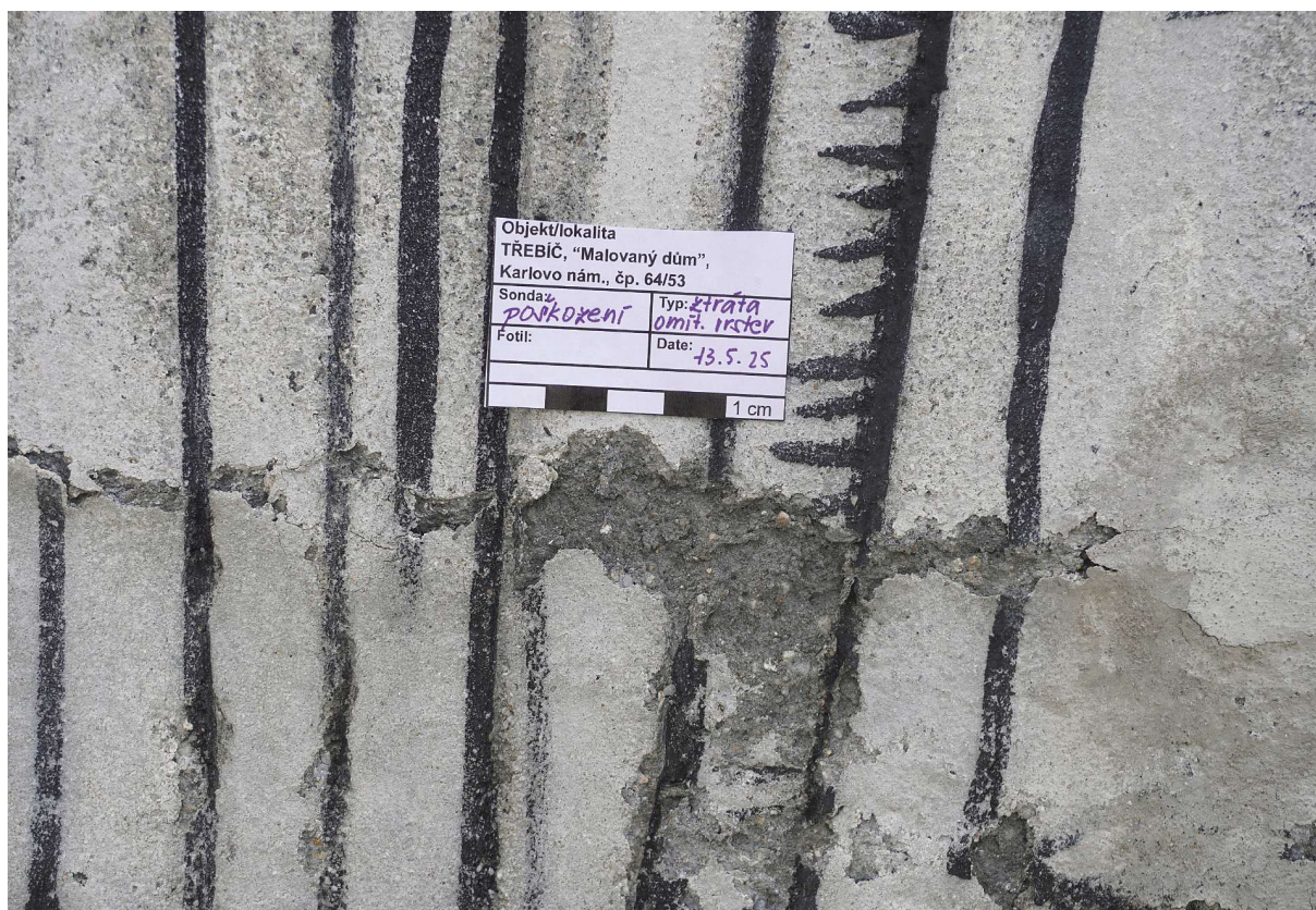
Obr. 09: V některých částech dochází k částečné ztrátě omítkových vrstev, čímž se vytváří krusty v omítkách.
