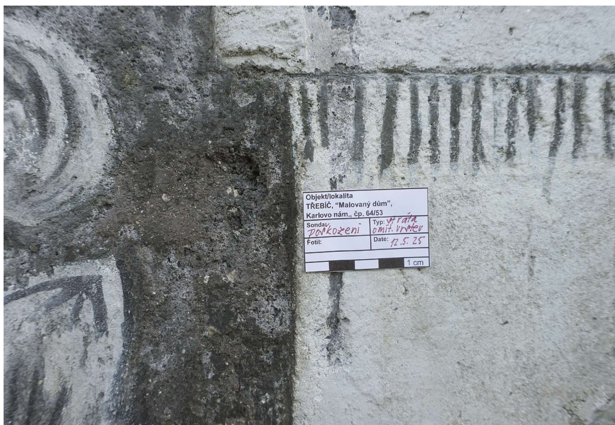
Obr. 07: Fasáda Malovaného domu na Karlově náměstí. Omítky se od podkladu výrazně oddělují, čímž dochází k vytváření dutin a trhlin.
