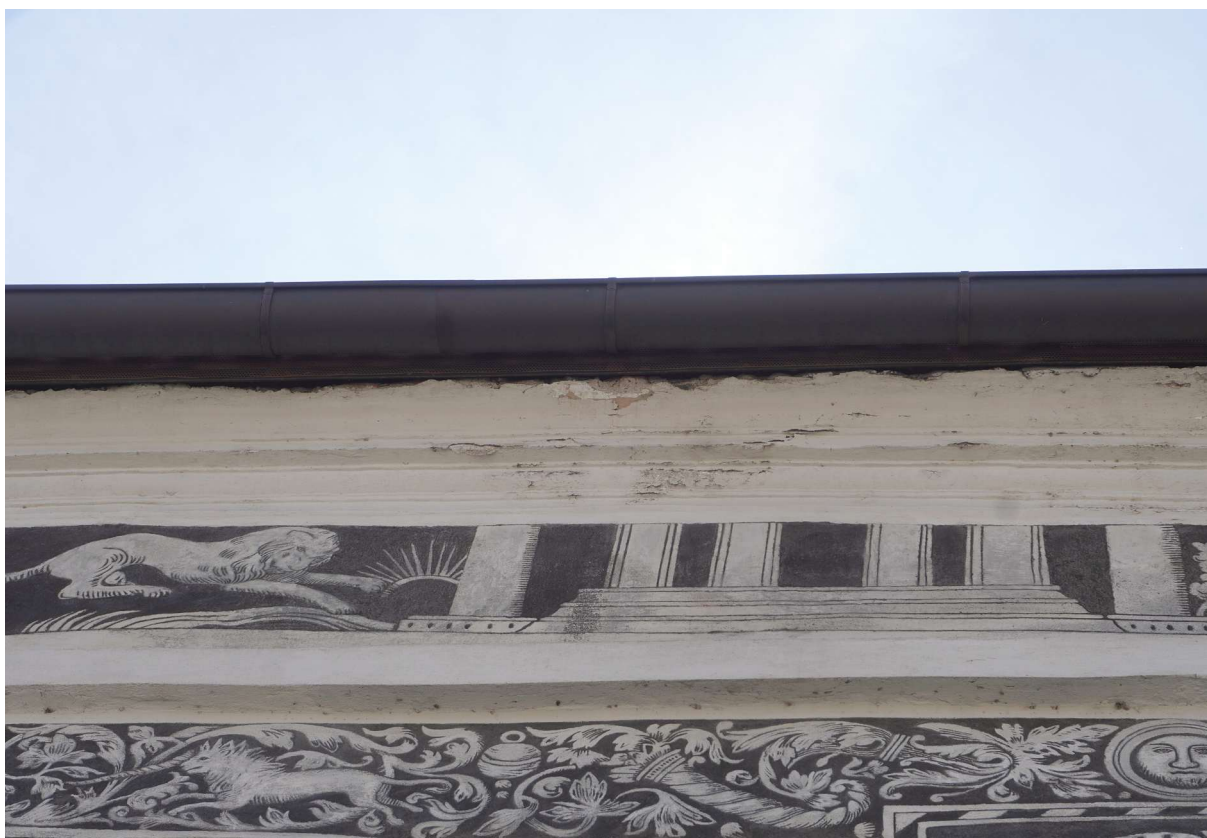
Obr. 03: Horní část Malovaného domu. Viditelné praskliny a chybějící místa na římse pod střechou.
