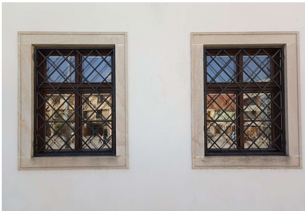
Obr. 12: Okenní šambrány jsou znečištěny od atmosférických a prachových depozitů. Některé spáry kamenných prvků jsou nesoudržné a drolí se.
