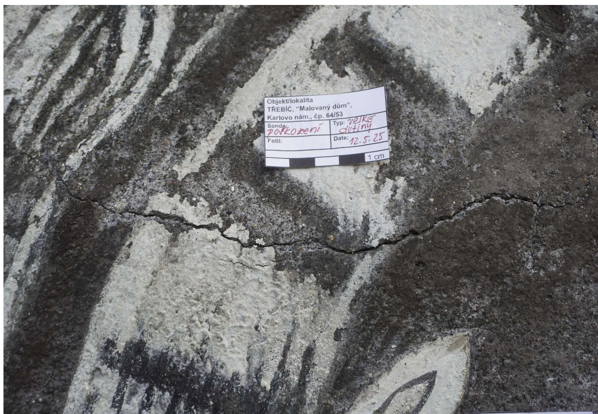
Obr. 07: Fasáda Malovaného domu na Karlově náměstí. Omítky se od podkladu výrazně oddělují, čímž dochází k vytváření dutin a trhlin.
