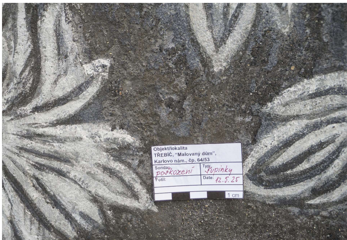
Obr. 11: Druhotná barevná vrstva v pozadí šupinkovatí a odlupuje se.
