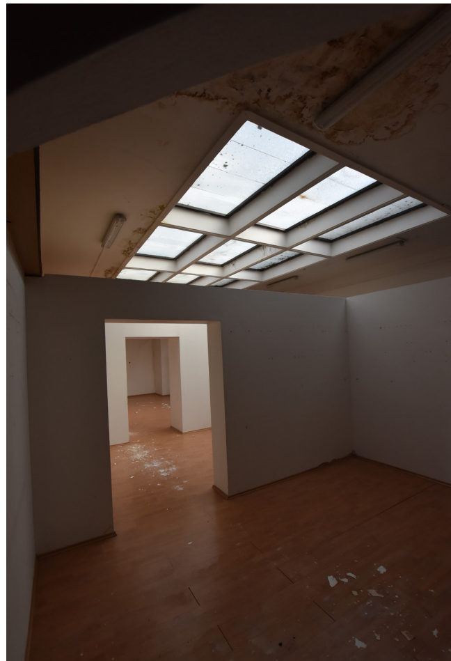
2NP - centrální chodba se světlíkem
