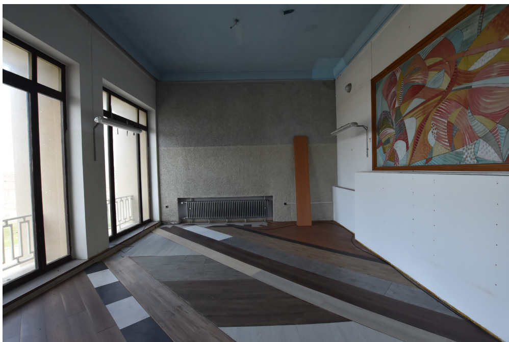
mezipatro nad vstupem
