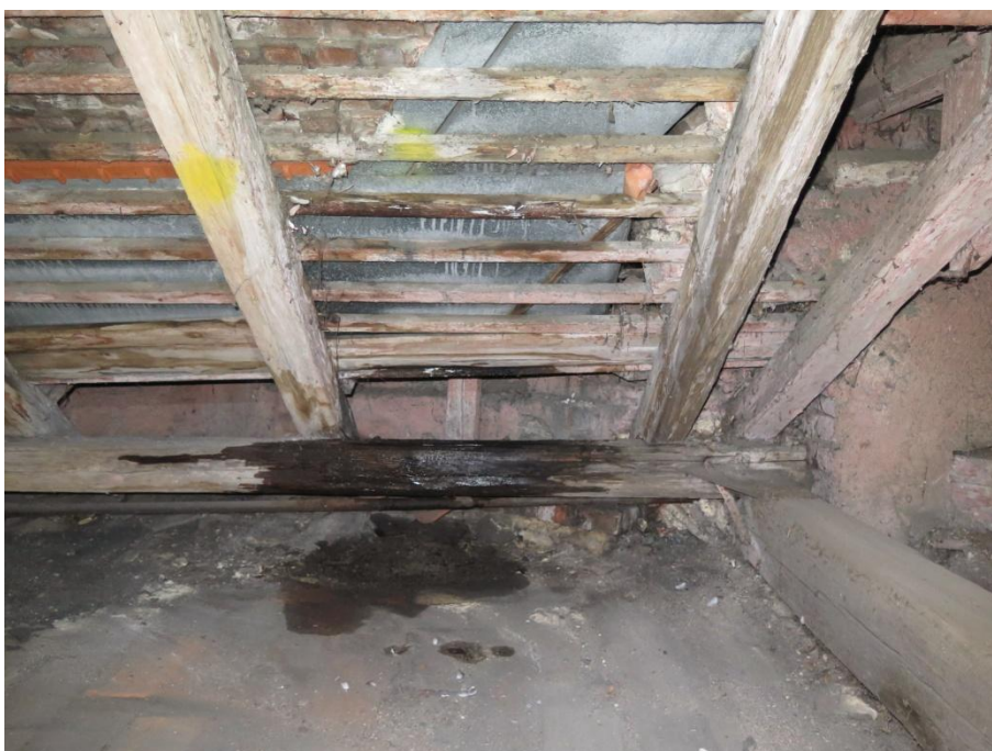
Foto 28: Oblast zatékání a aktivního napadení pozednice dřevokaznými houbami – u zaatykového žlabu.
