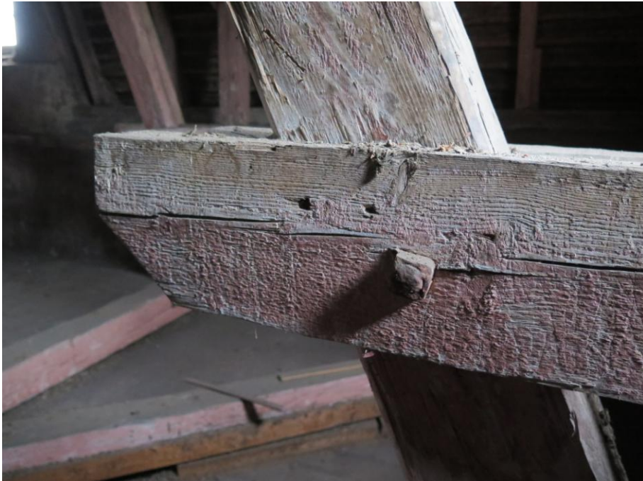
Foto 3: Detail – řezaná kleština, tesaná vzpěra, svorník se čtyřhrannou maticí.
