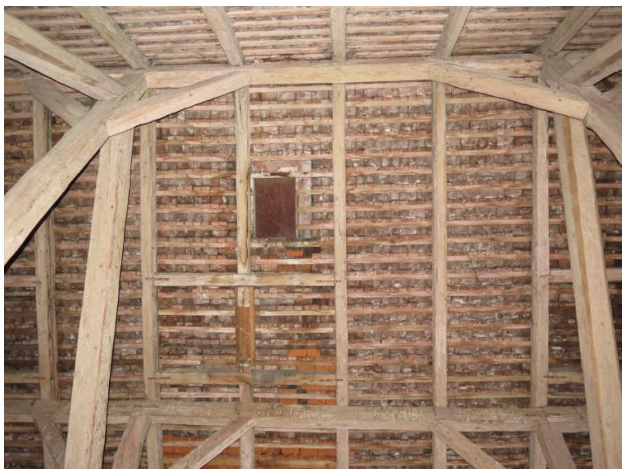
Foto 18: Výměny krokví pro již dříve zrušená komínová tělesa.
