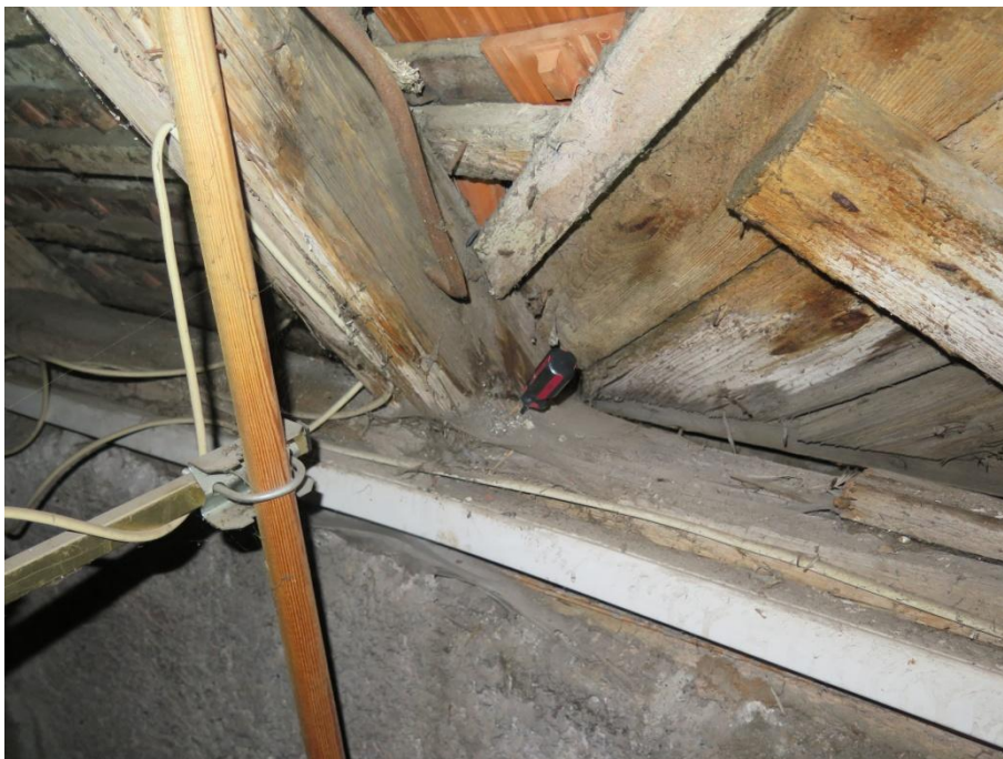
Foto 21: Poškození okapní vaznice (pozednice) a paty krokve u vikýře hnilobou.
