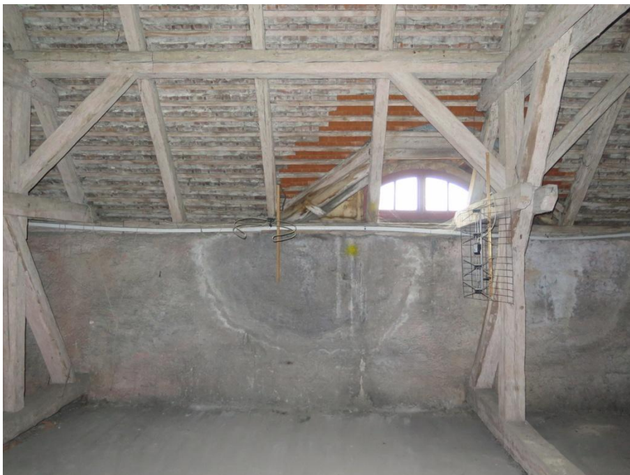
Foto 19: Pohled na oblast zatékání kolem jednoho z vikýřů středního traktu.
