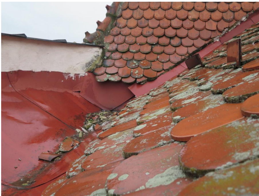
Foto 29: Pohled na zaatykový žlab – oblast zatékání.
