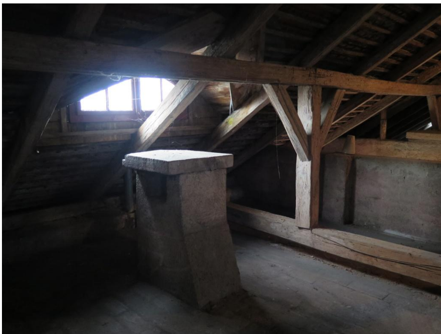
Foto 6: Vyústění větrací šachty do podkrovního prostoru.
