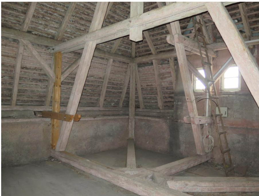
Foto 15: Pohled do mansardové části s měněnými prvky a zatékáním u vikýře.
