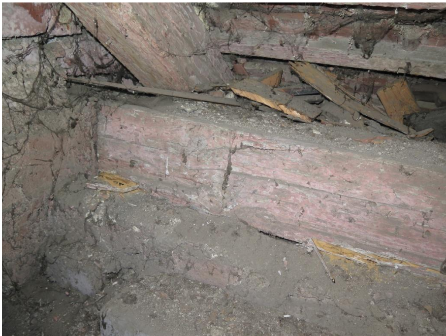
Foto 14: Pozednice poškozená hnilobou.
