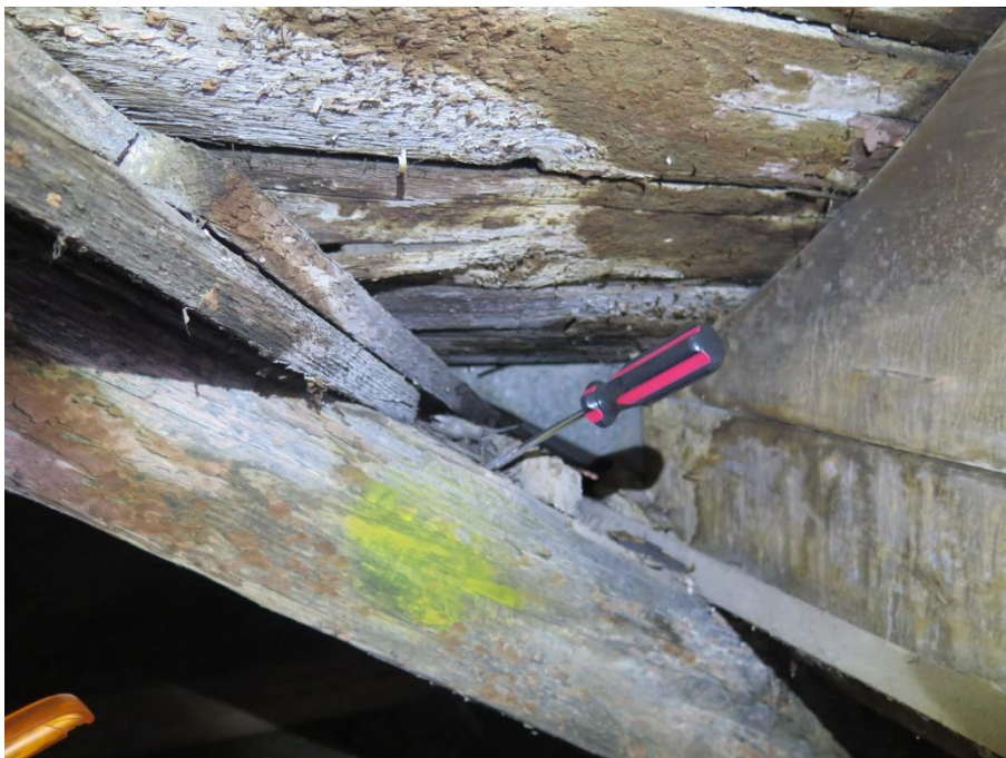
Foto 27: Detail poškození krokve a bednění vikýře dřevokaznými houbami.
