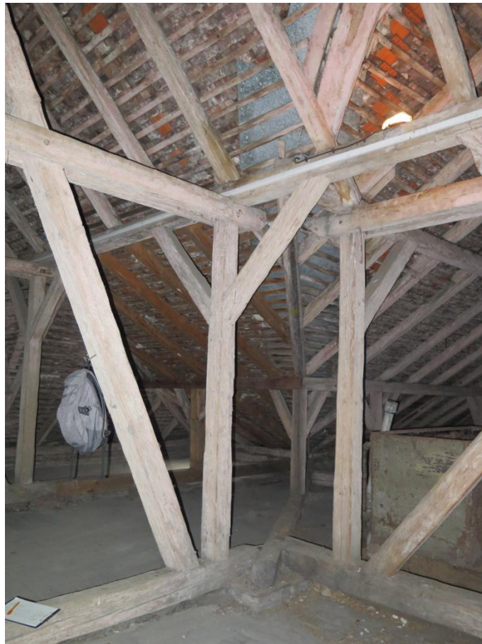
Foto 11: Pohled na poškozené úžlabí u západního traktu.
