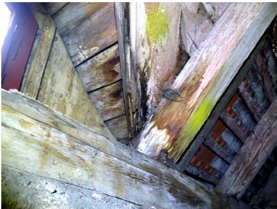
Foto 22: Poškození okapní vaznice (pozednice), paty krokve a bednění jednoho z vikýřů dřevokaznou houbou – plodnice koniofory
