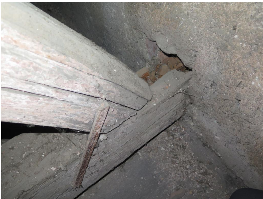
Foto 23: Poškození zhlaví vazného trámu dřevokaznou houbou z rodu trámovek.
