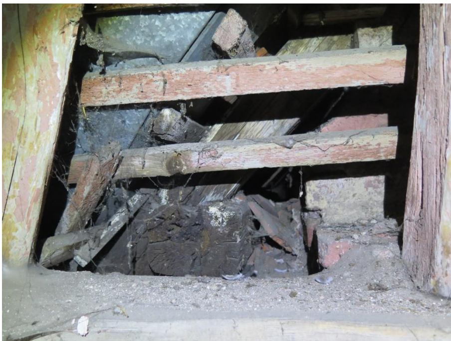
Foto 26: Detail aktivního napadení pozednice a námětků dřevokaznými houbami.
