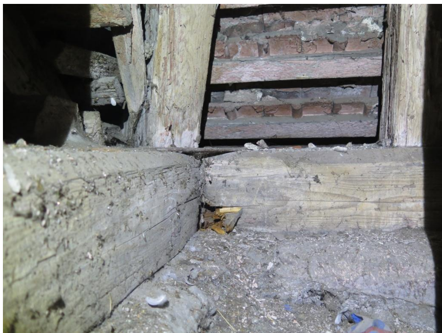
Foto 17: Pozednice (okapní vaznice) na nároží poškozené hnilobou.
