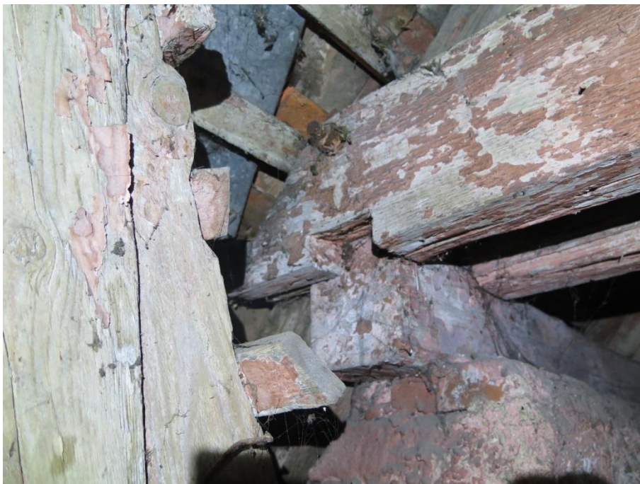
Foto 25: Detail tesařského spoje okapní vaznice (pozednice) s kleštinami.
