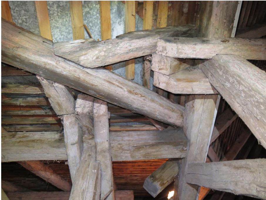
Foto 13: Poškozené úžlabí mezi západním a středním traktem.
