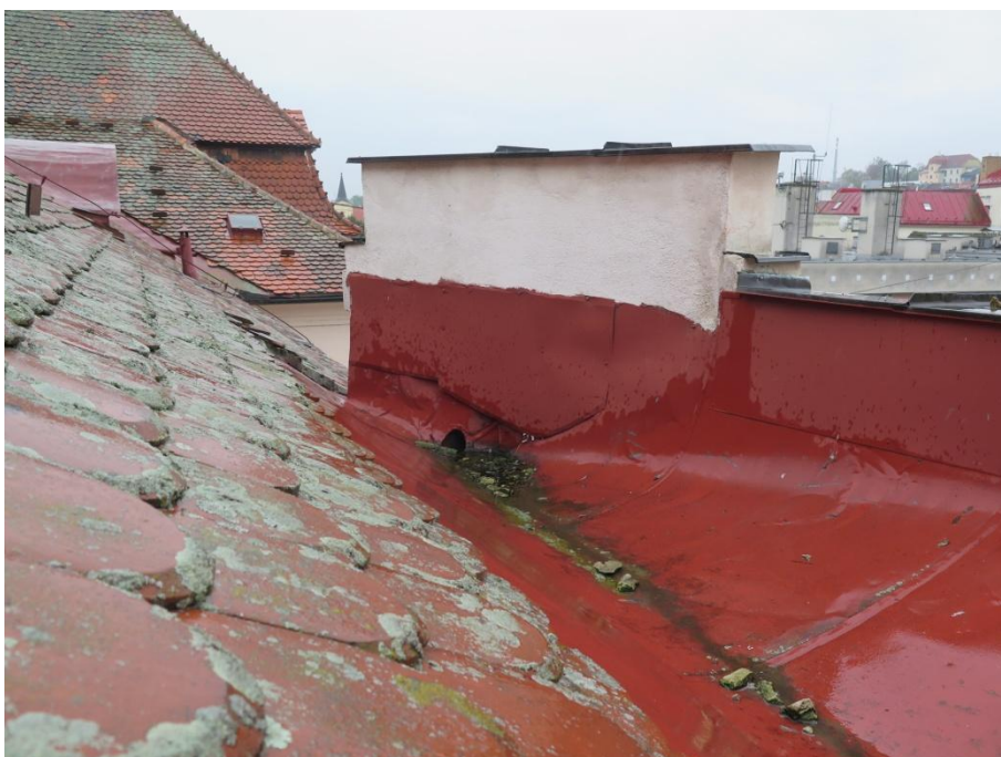
Foto 30: Pohled na zaatykový žlab – nedostatečná dimenze odtokové vpusti.
