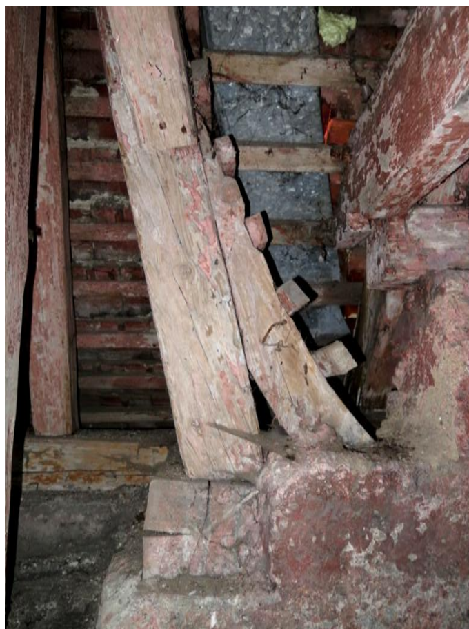
Foto 24: Atypický skružový námětek mansardové části krovu, se zapuštěnými latěmi.
