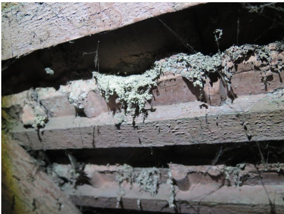
Foto 8: Střešní tašky kladené na maltu s příměsí zvířecích chlupů.
