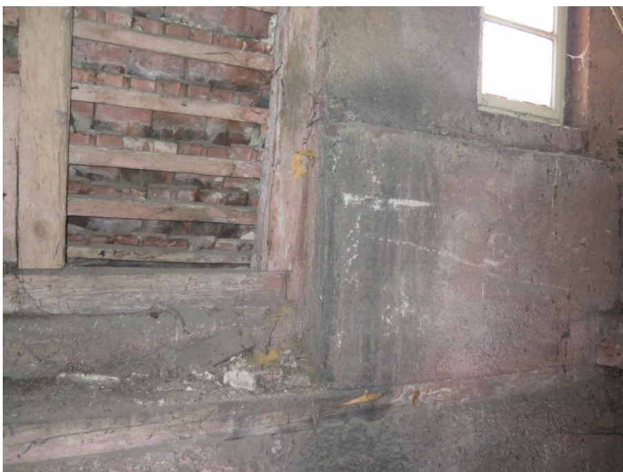
Foto 16: Oblast zatékání kolem jednoho ze zděných vikýřů + poškození tesaříkem.
