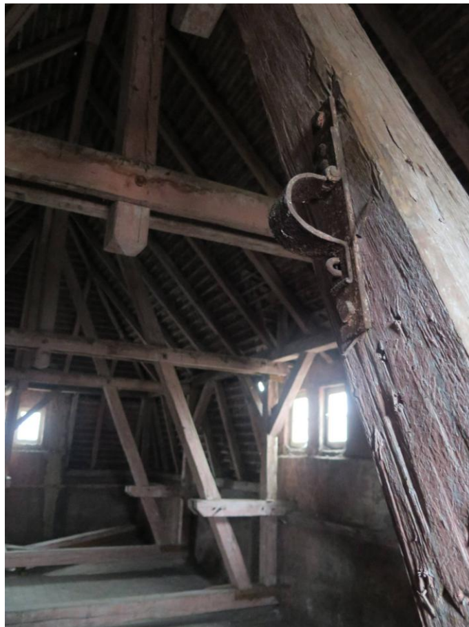
Foto 4: Detail – kování pro uchycení žerdi od praporu.
