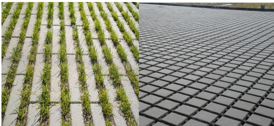
Příklady vodopropustné úpravy zpevněných parkovacích a odstavných ploch
