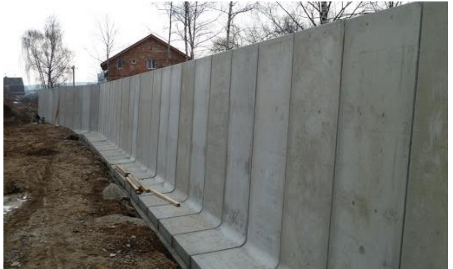
Příklad betonové prefabrikované opěrné zdi
